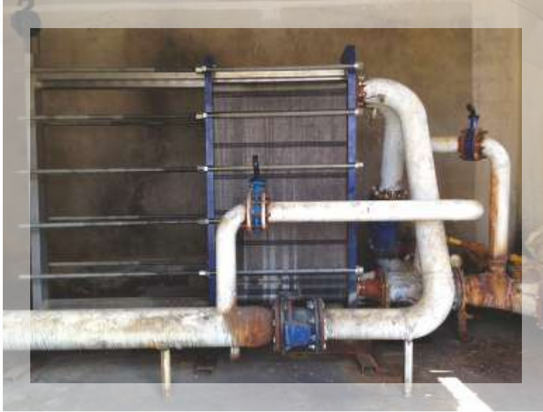
Eşanjör Dairesi Eski Hali
